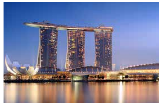
Für das Fünf-Sterne-Hotel Marina Bay in Singapur fertigte SMW 43 Liftanlagen.
